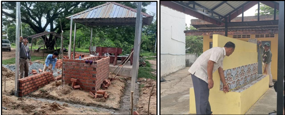
Figura 4 Monitoraggio durante la costruzione delle stazioni di lavaggio mani e latrine
